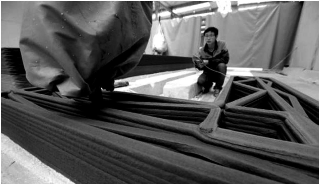
geprint prefab onderdeel, met vooraan op de foto de printkop
